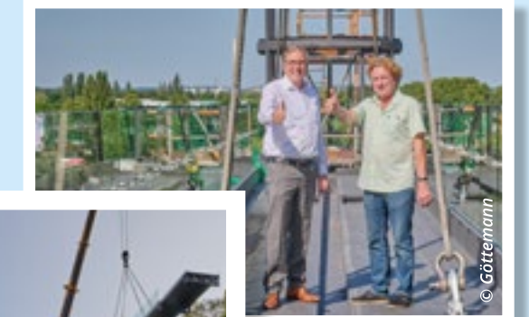
Oben: Oberbürgermeister Herzing und der verantwortliche Architekt Schmuck treffen sich auf dem gerade eingehobenen Steg.
