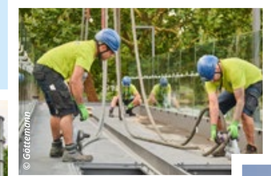
Rechts: Der Steg wird an den Stahlseilen des Krans befestigt.
