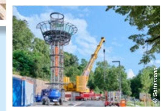
Oben: Vorbereitung zum Einheben des Steges.
