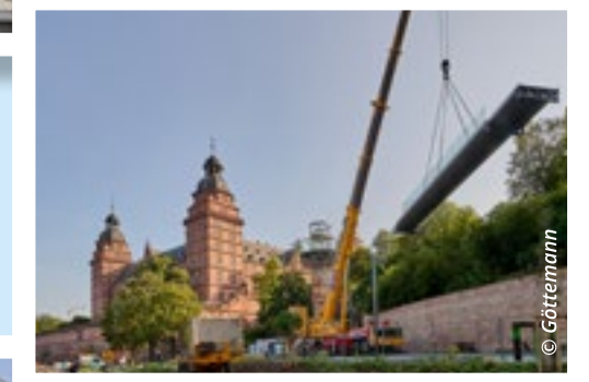
Links: Die letzten Meter, gleich wird der Steg am Aufzugsturm fixiert.
