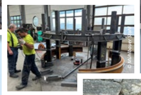
Rechts: Konstruktionsarbeiten beim Stahlbau des Aufzugsturmes.
